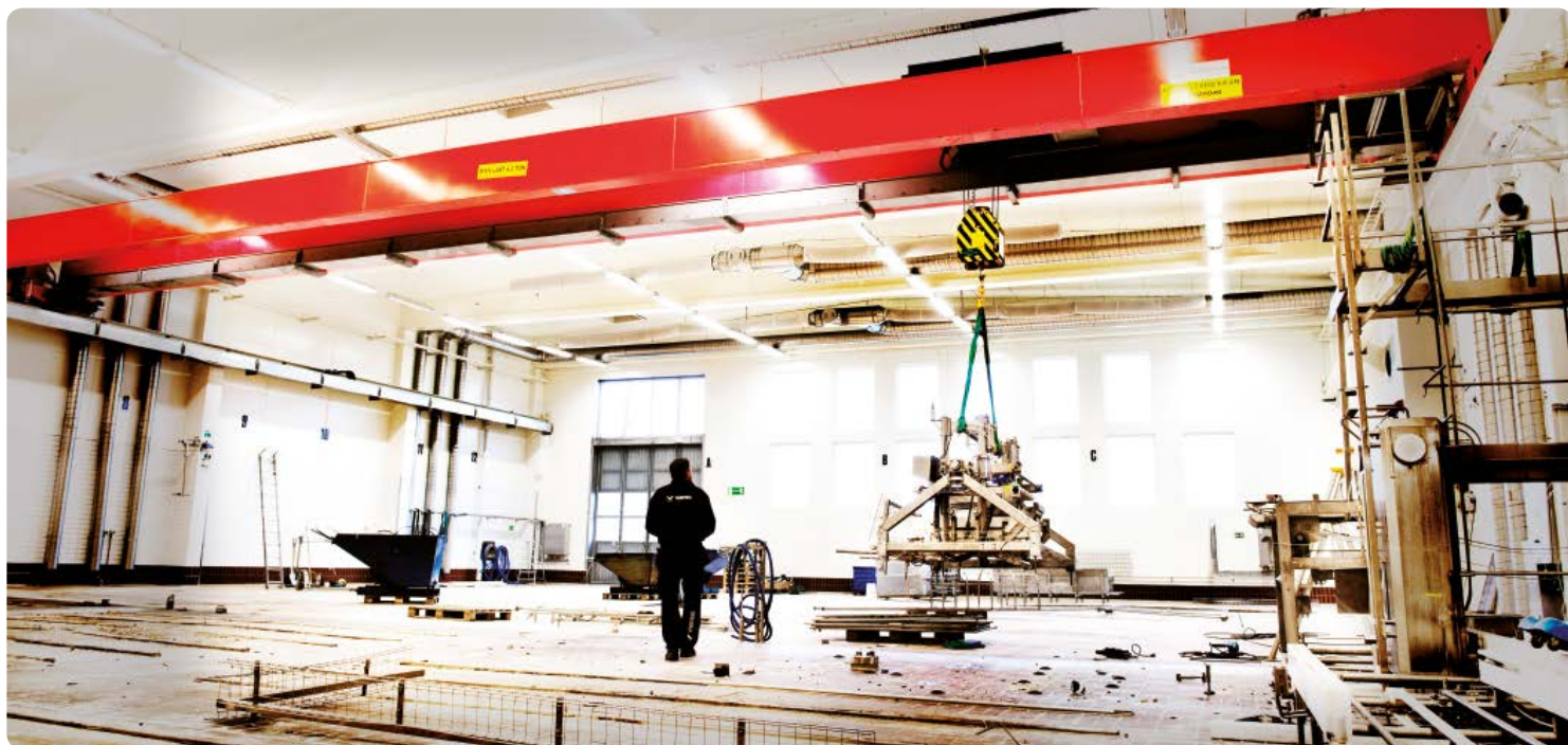
Den sista arbetsuppgiften för traversen från JJ Gruppen blev att vara behjälplig vid demoneringen av produktionsutrustningen i ostfabriken.
