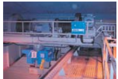
Totalrenoverad pryder den mer än 60 år gamla traversen sin plats i vattenkraftverket. Med ABUS hjälplyft samt elektronik och radiostyrning från 2000-talet har ProCranes gjort den både mer lättmanövrerad och betydligt säkrare att använda!
